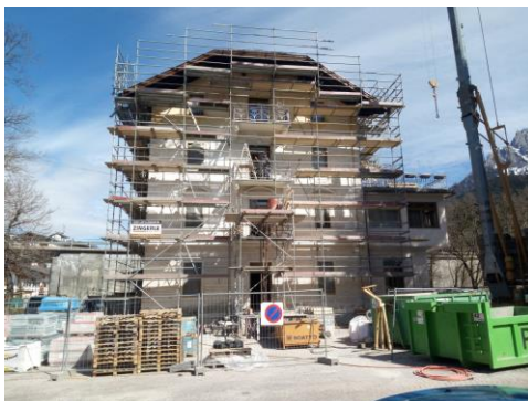
Lavori di ristrutturazione
