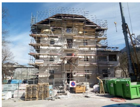
Lavori di ristrutturazione
